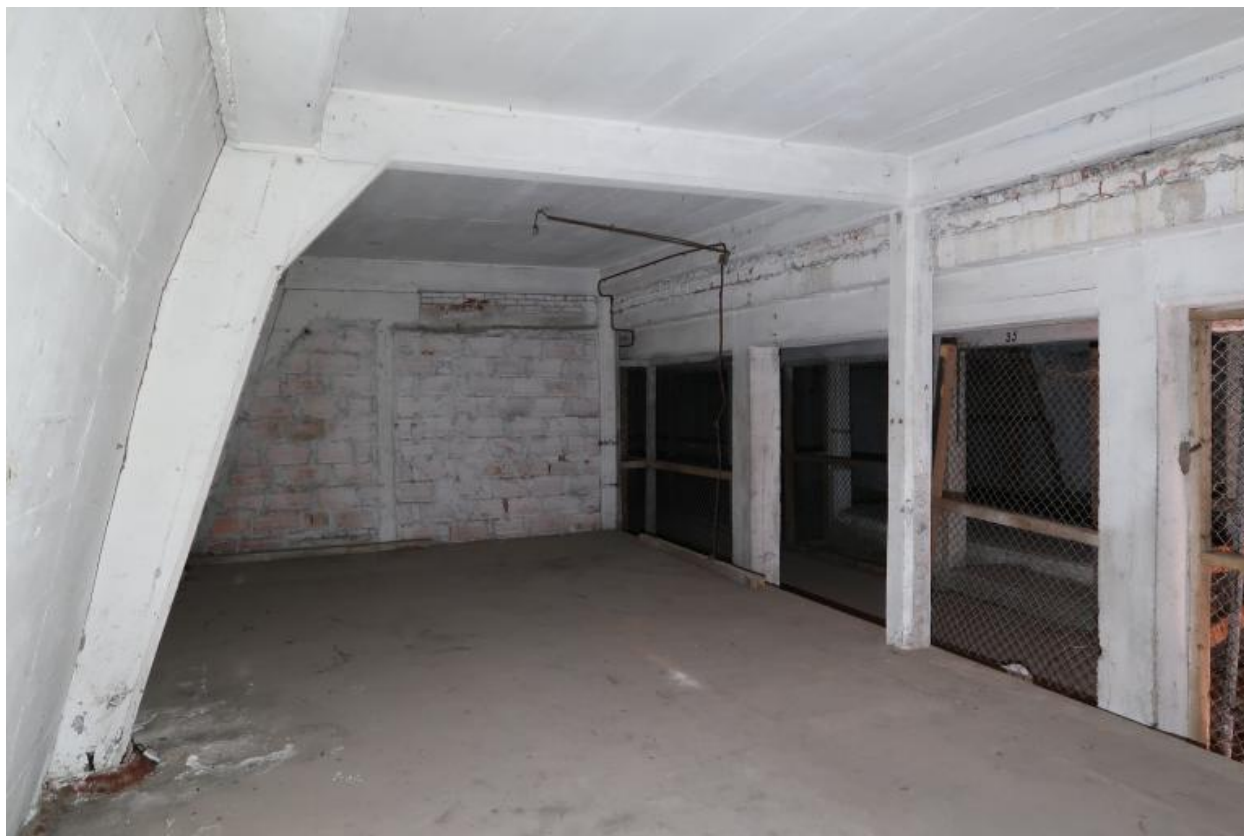
Premier étage : extrémité sud, box 35
