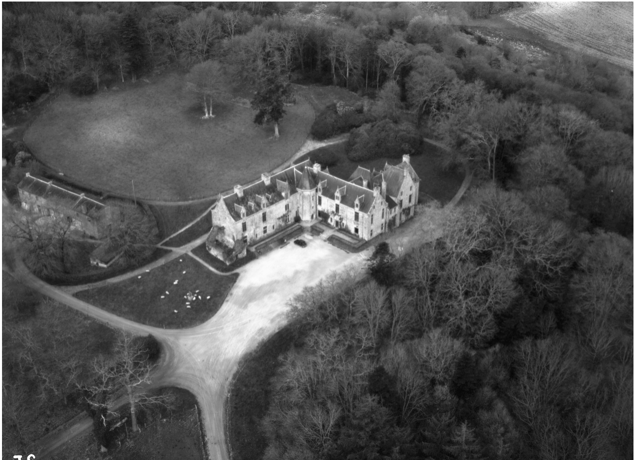
Vue aérienne sud-ouest
