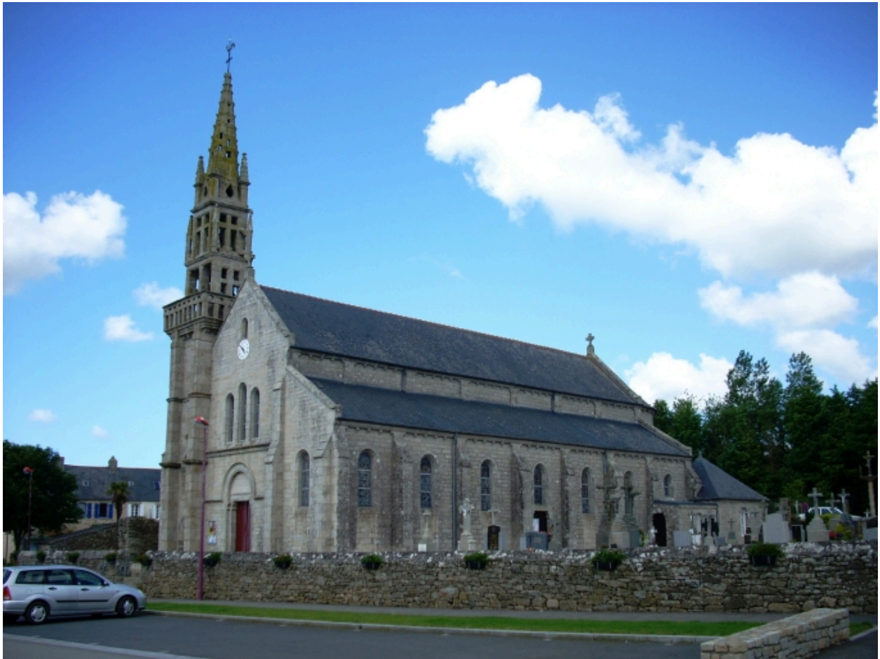
Trégarantec, église paroissiale Saint-Théarnec : vue générale sud-ouest
