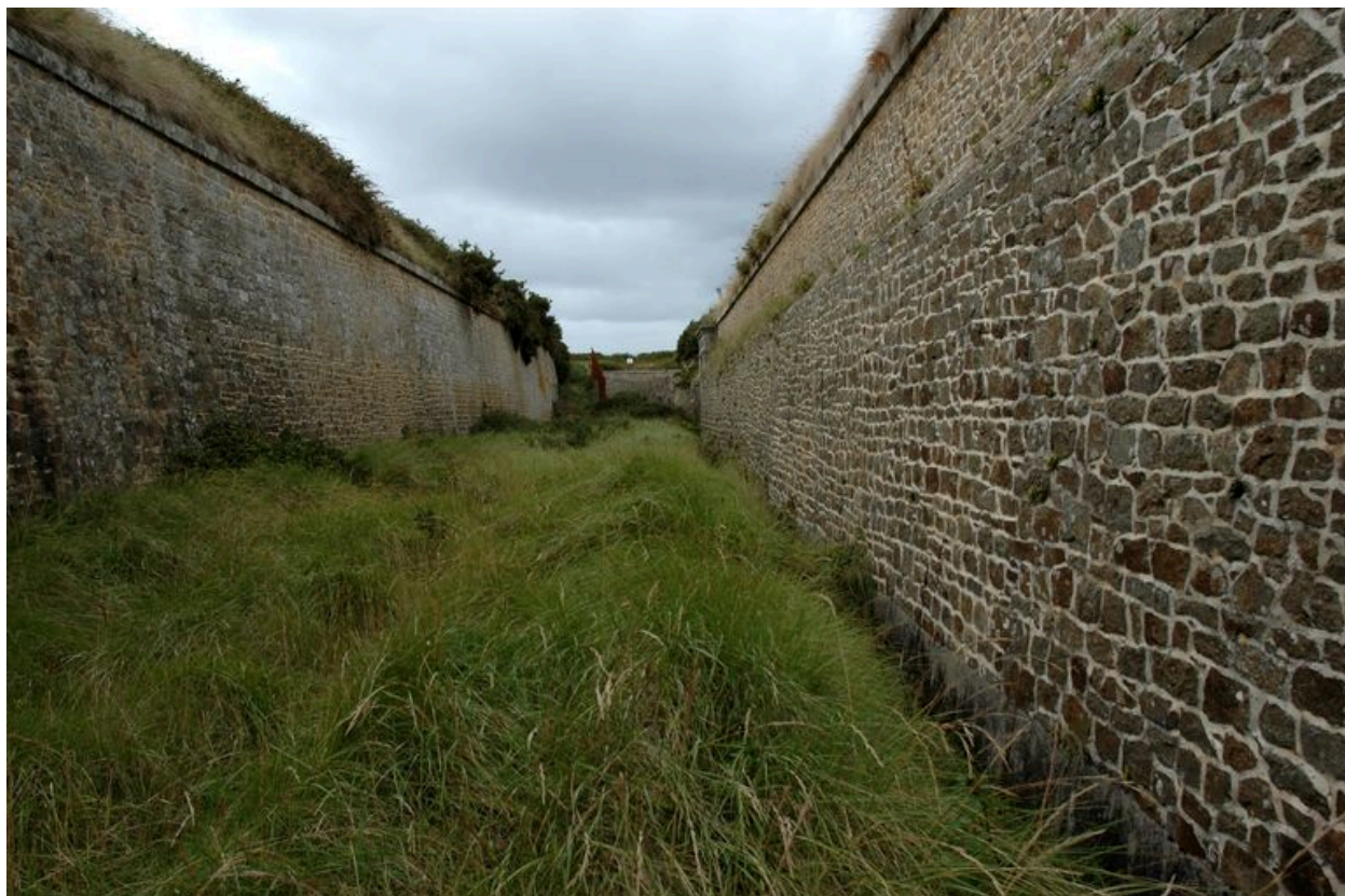
Vue du fossé sec du front sud-ouest
