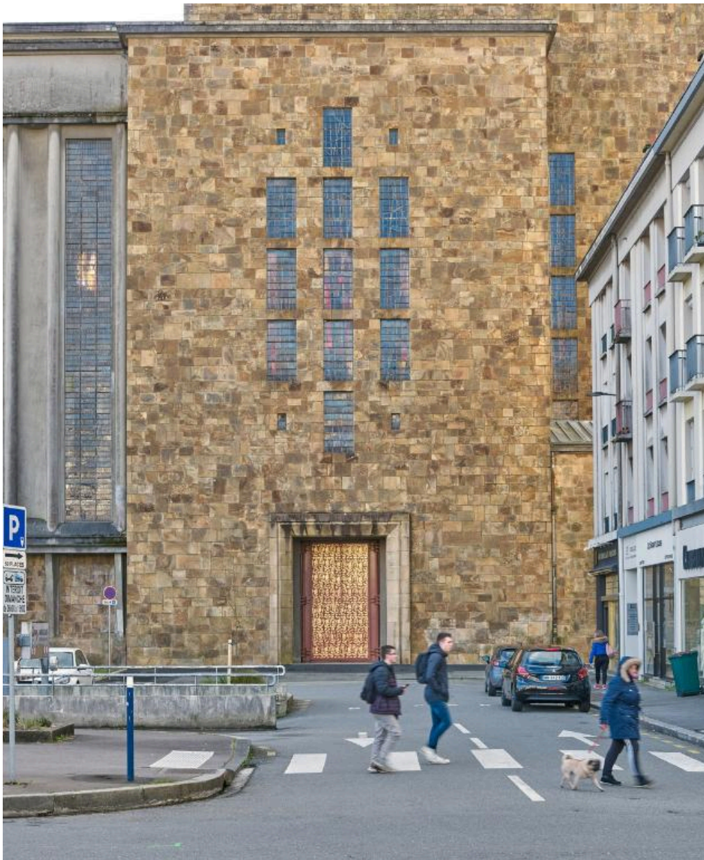
Eglise Saint-Louis, élévation mur ouest, portail ouest
