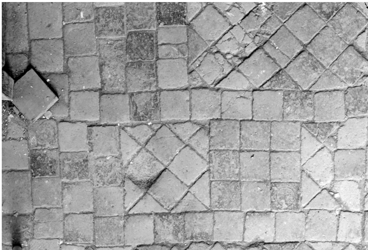
Détail des tomettes du sol
