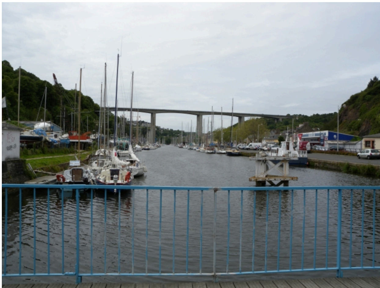
Vue en aval du bassin à flot réservé à la plaisance
