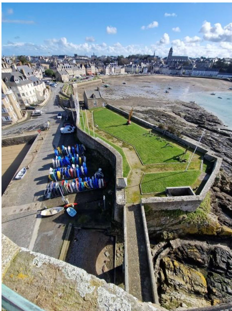
Vue générale de la basse-cour depuis le parapet de la tour. A gauche, la cale de l'anse Solidor. En arrière-plan, Saint-Servan
