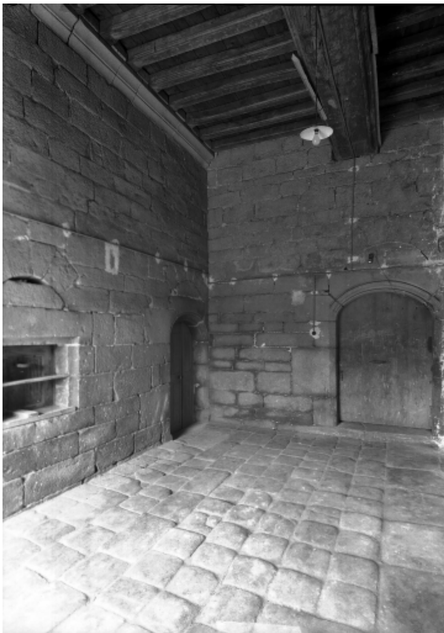
Rez-de-chaussée, vestibule : vue générale prise du sud est
