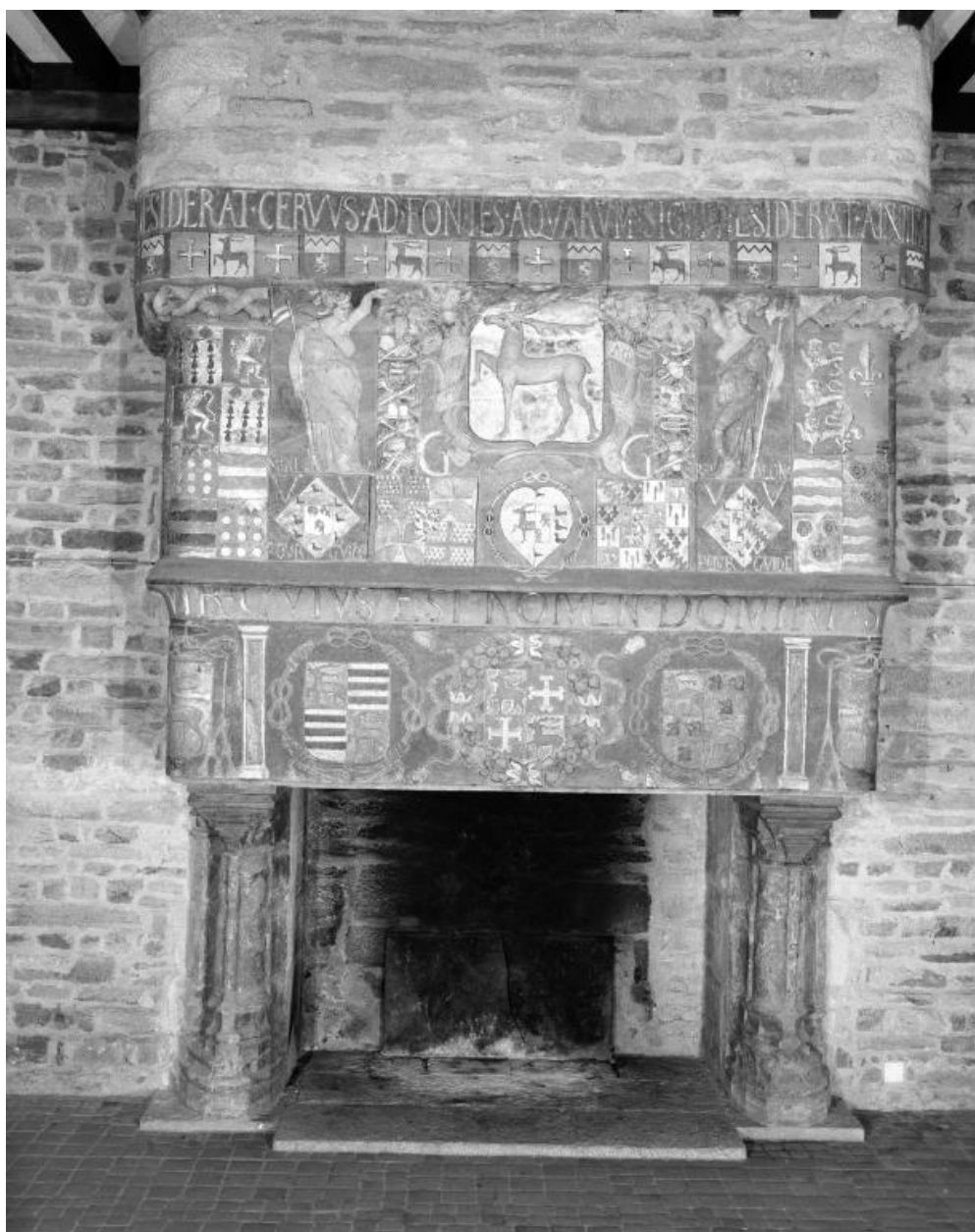
Cheminée, vue générale de face.
