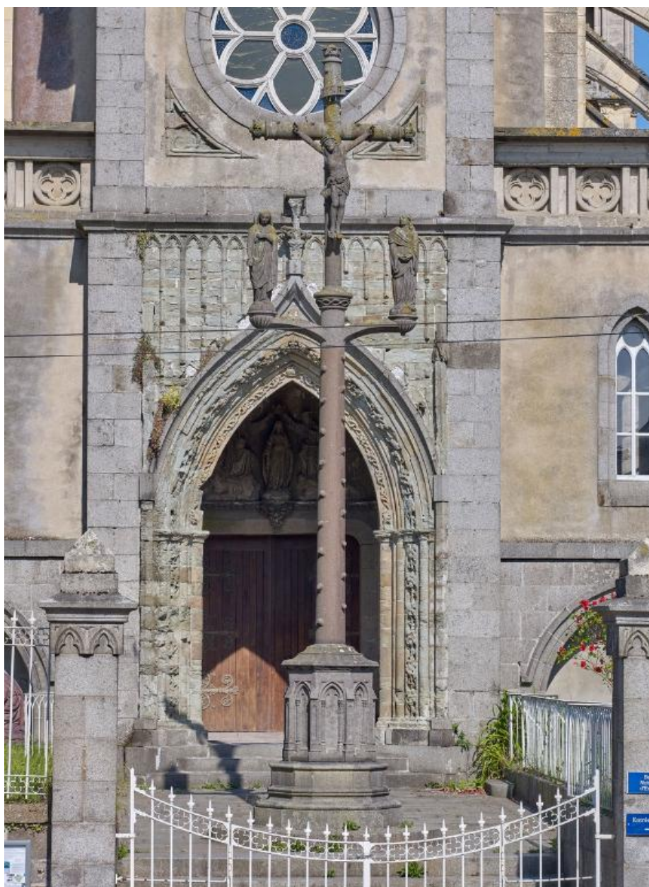
Vue du portail du porche en façade ouest
