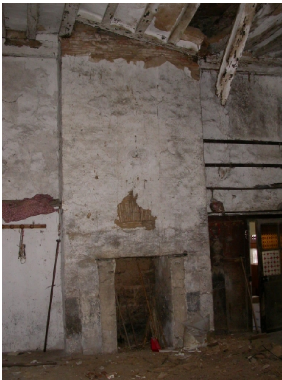
Cheminée de la partie arrière
