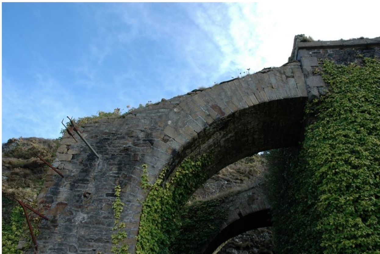
Vue de la caserne défensive Robert : détail de l'arc-boutant est
