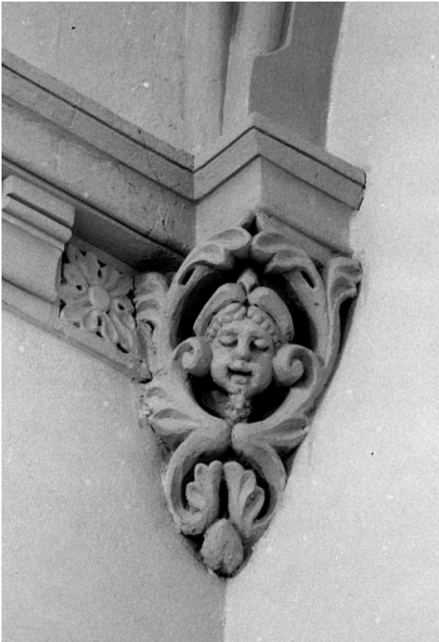
Intérieur, bras Sud du transept : détail du culot et de la corniche.
