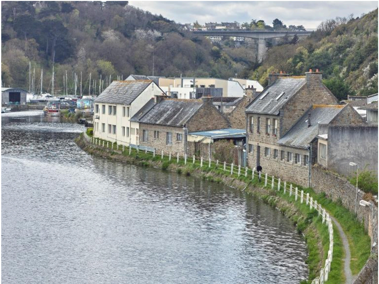
Les bâtiments de l'usine et le bassin à flot, en arrière-plan de viaduc de la R.N.12
