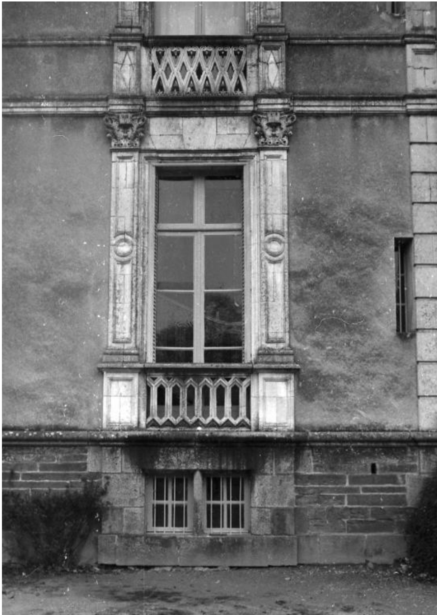
Façade sud, détail de fenêtre.
