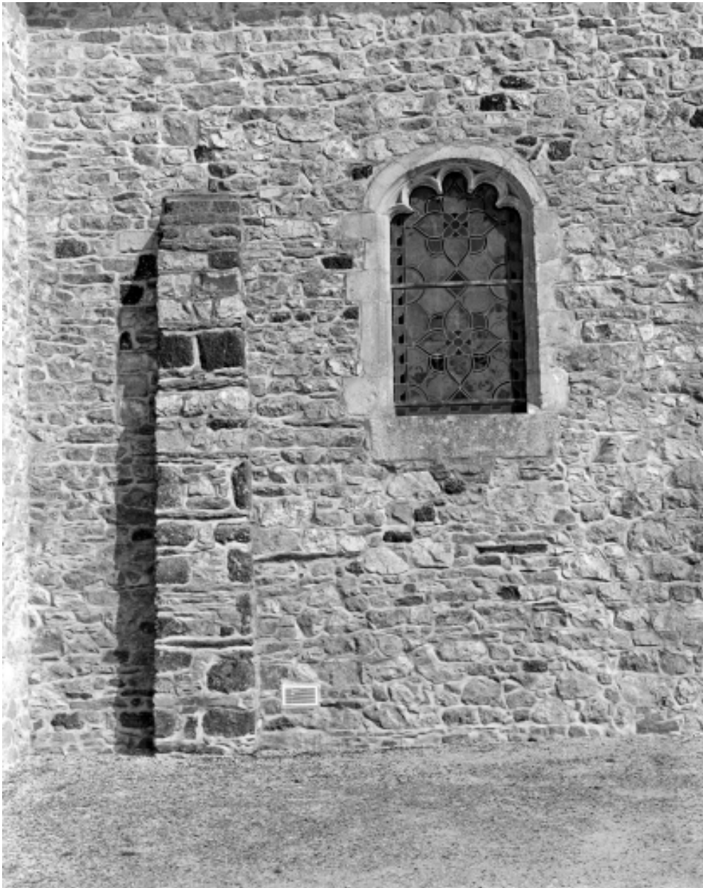
Extérieur, détail de la fenêtre et contrefort du mur sud du choeur.
