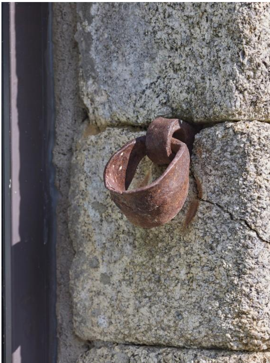
Logis à fonctions multiples, 2e moitié 17e siècle. Entrée du logis. Anneau de porte à husset pincé entre deux pierres
