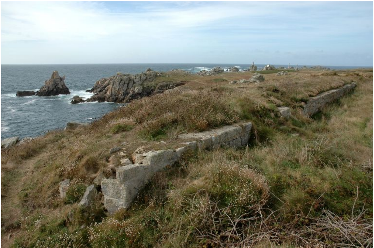
Vue de la batterie rectangulaire de Loqueltas, joue intérieure du parapet en granite
