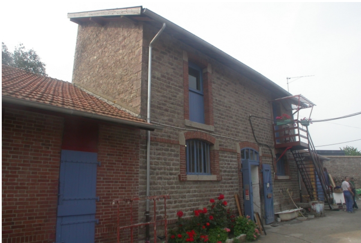
Vue générale du bâtiment sud
