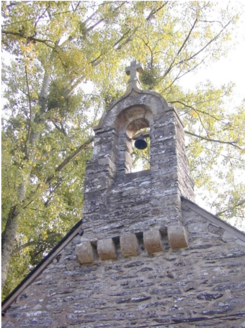
Le clocheton : vue générale sud-ouest
