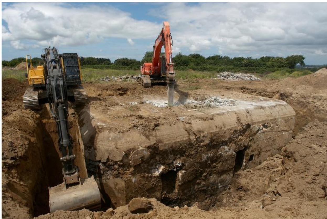
Déconstruction d'un bunker de type 502
