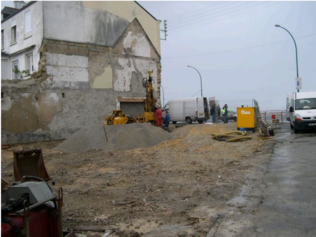
Chantier à l'emplacement de l'ancienne conserverie de sardines Béziers
