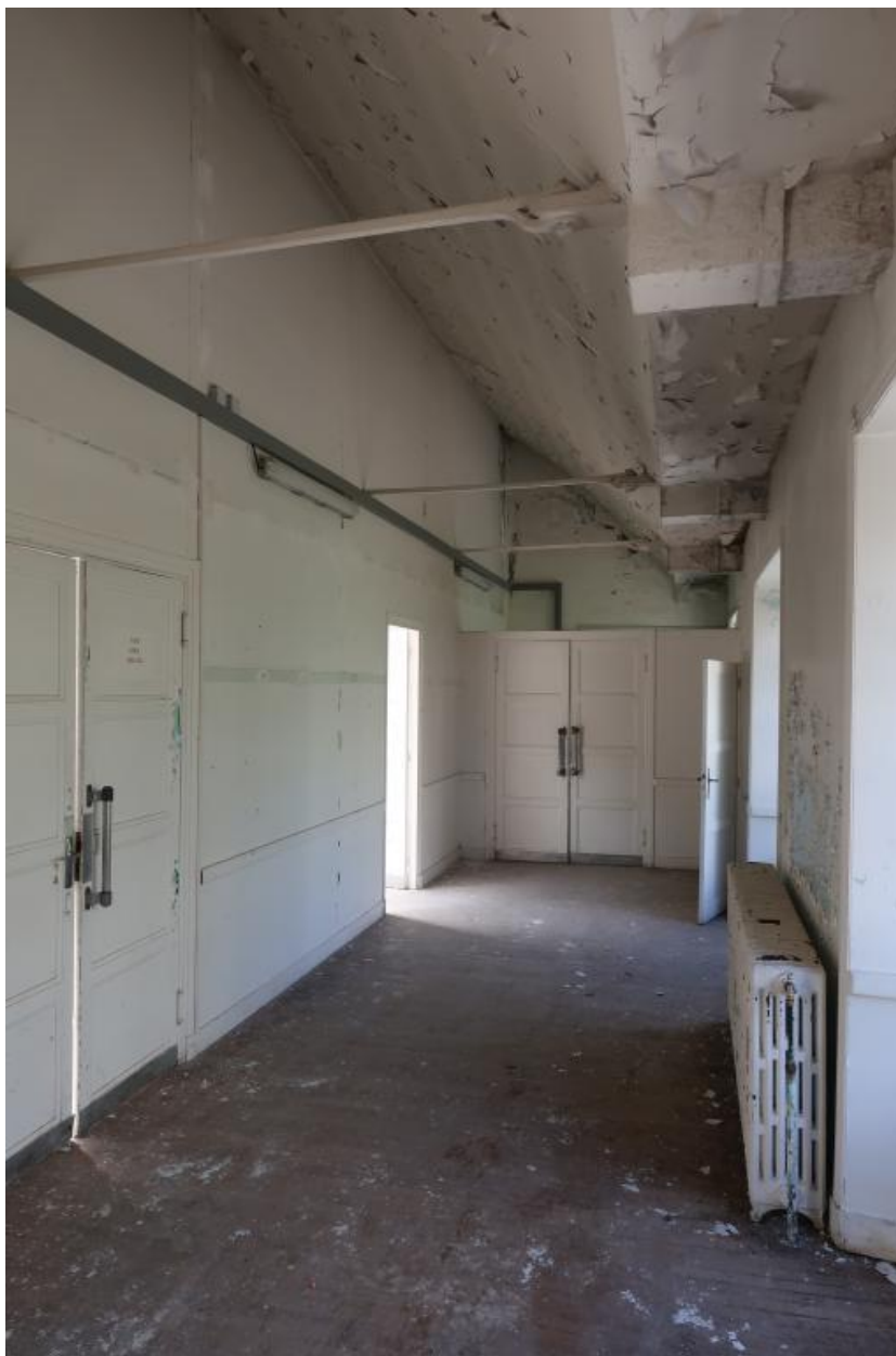
Vue intérieure : partie ouest, premier étage, couloir de distribution (état en 2022)
