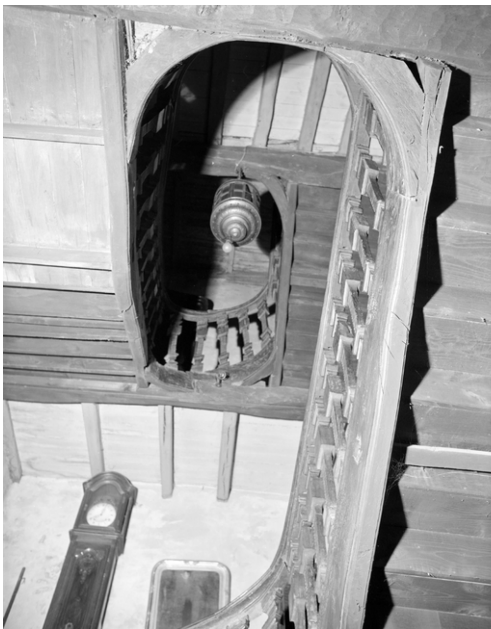
Escalier principal en bois à jour central
