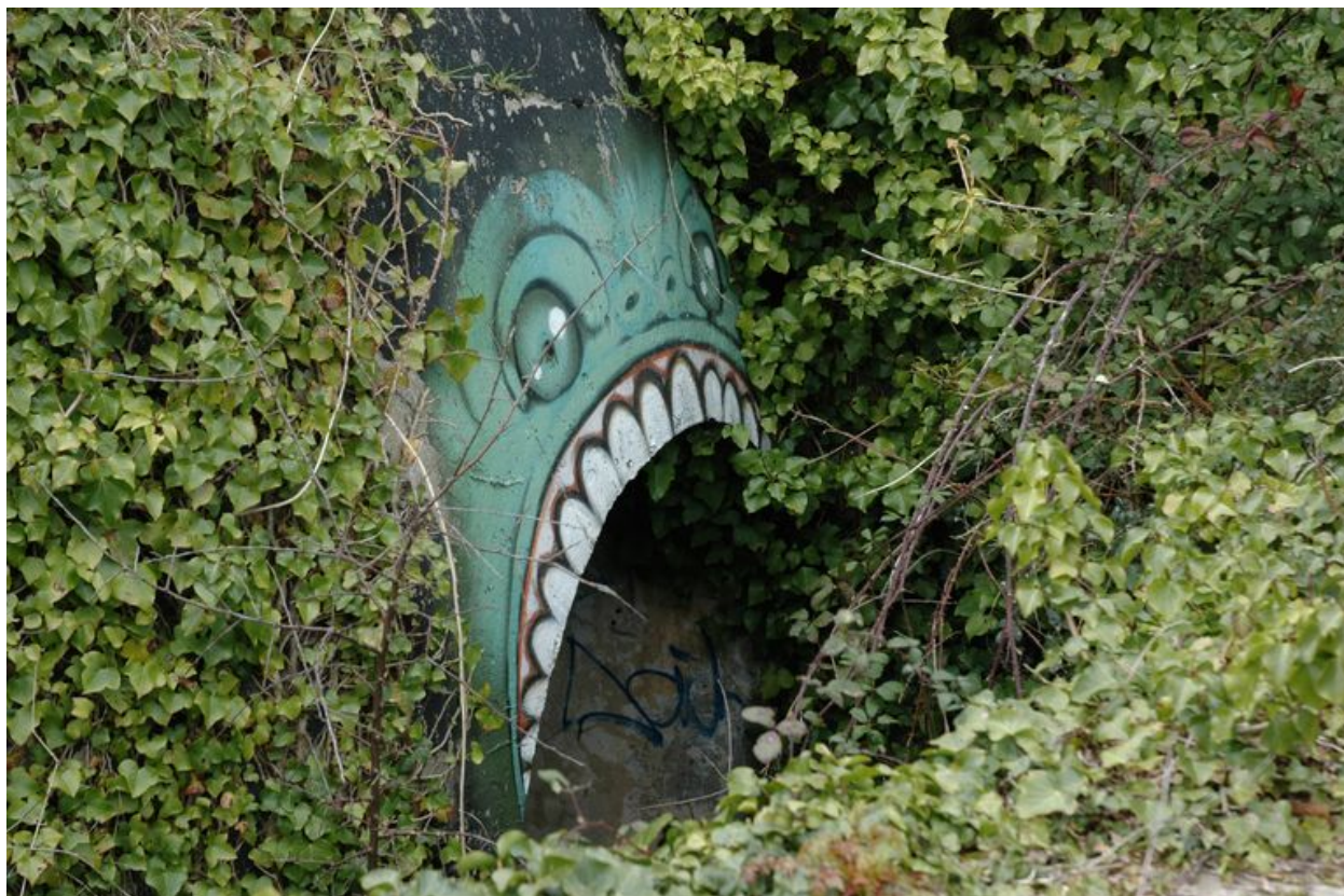
Vue de l'entrée de l'abri à munitions de sûreté (état en 2005)
