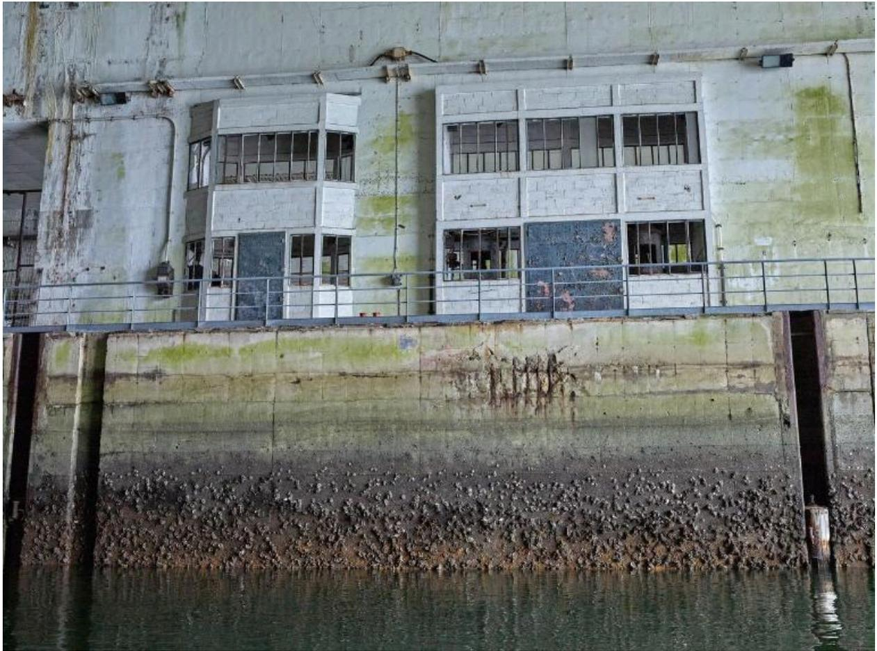
Vue de l'alvéole D : quai est (quai n° 19). Dans l'épaisseur du mur de refend entre les alvéoles D et E se trouvent les salles des pompes d'épuisement et d'assèchement
