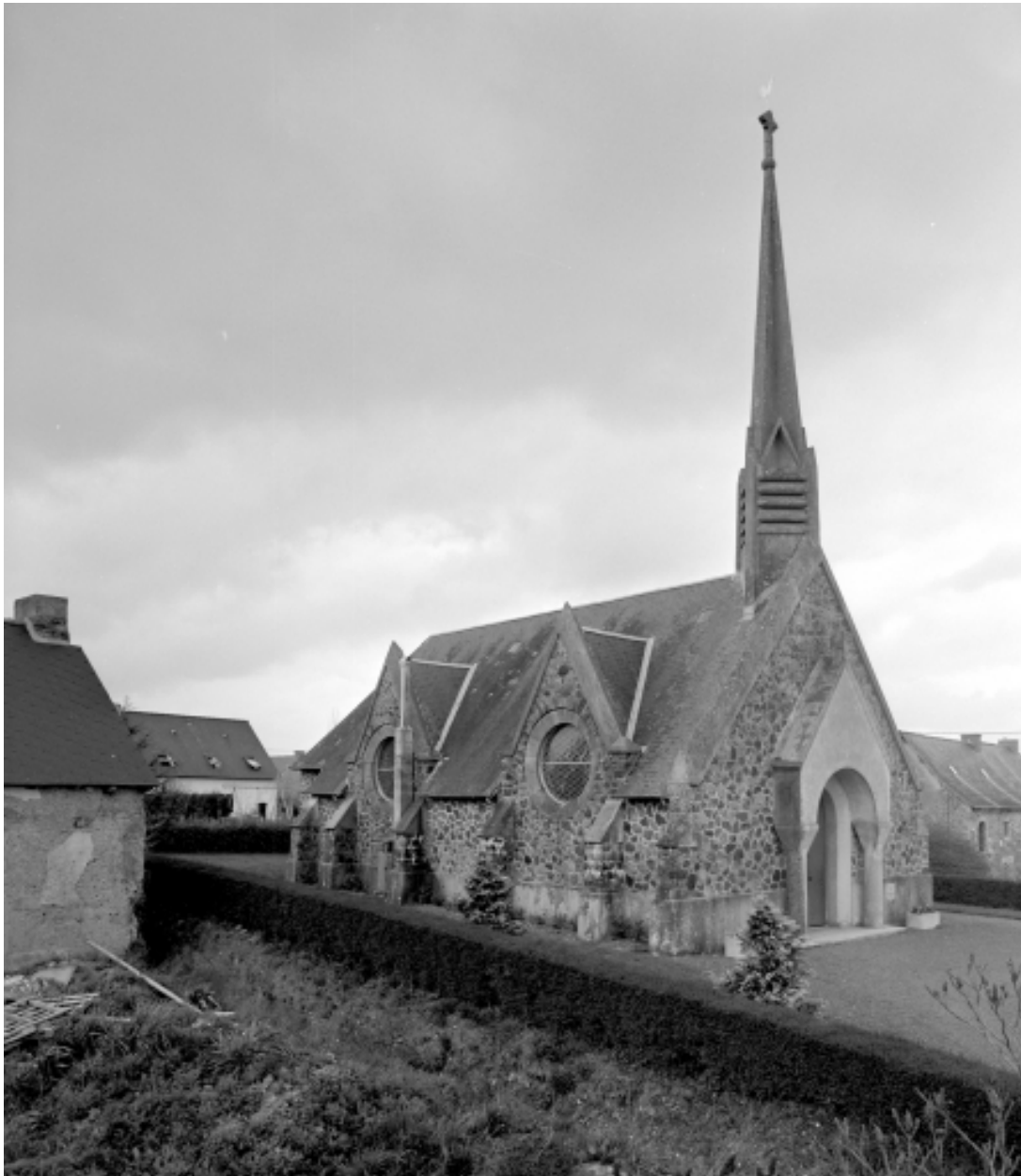
Elévation Ouest : vue générale
