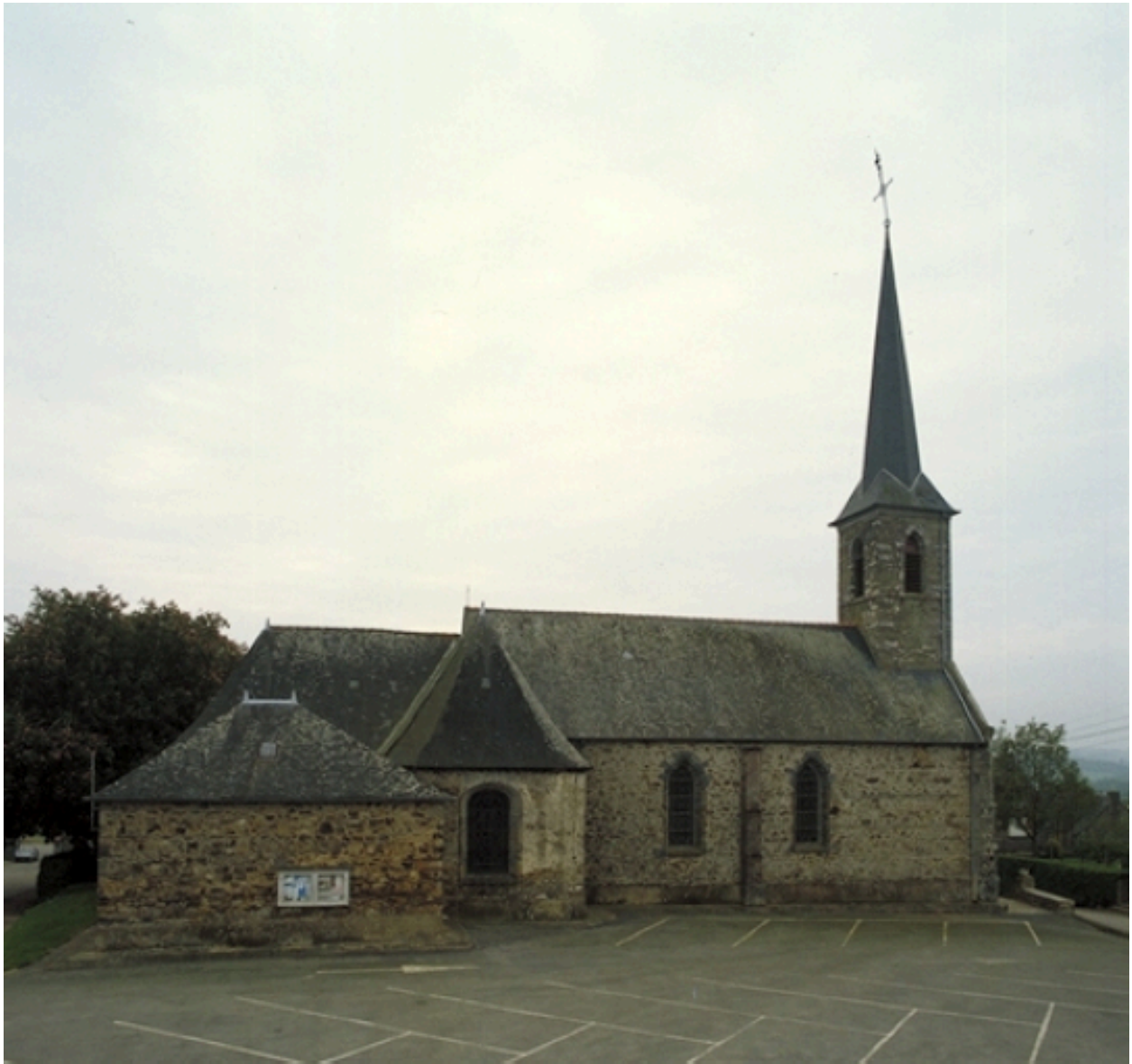
L'église : vue générale nord
