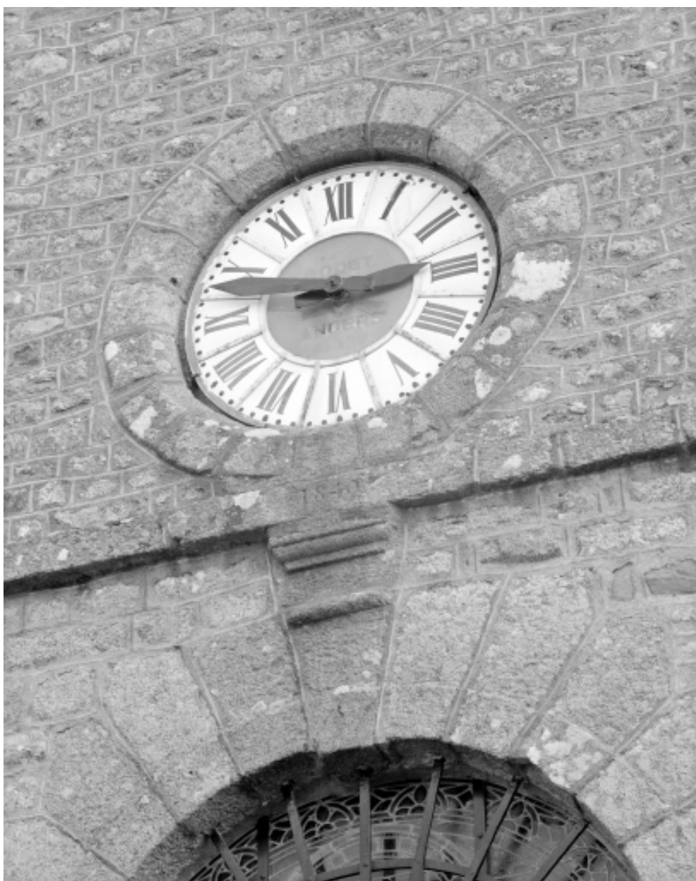
Elévation Ouest, horloge : vue générale
