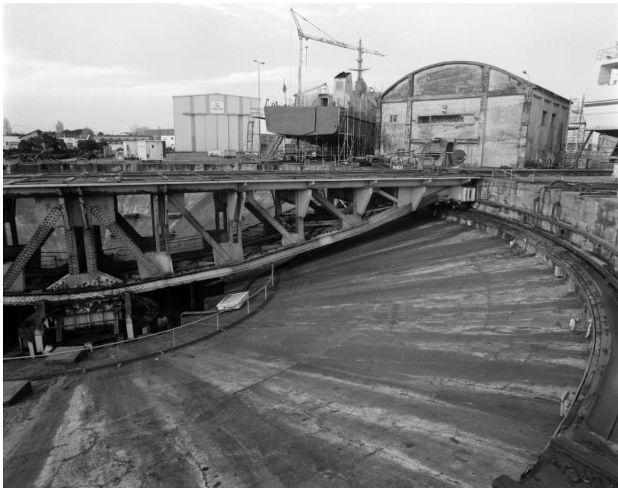
Vue du pont basculant et tournant dans sa fosse bétonné en 2000. Au droite, le bâtiment abritant le treuil de hissage principal du slipway
