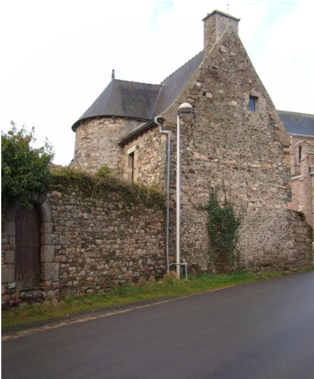
Paimpol, l'ancien bourg de Plounez. Maison à tour demi-hors-oeuvre sur élévation antérieure sur jardin (18ème siècle)
