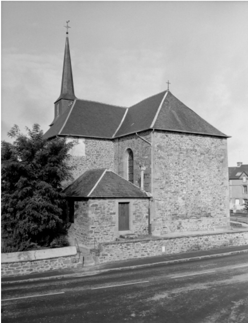
Elévation Est : vue générale
