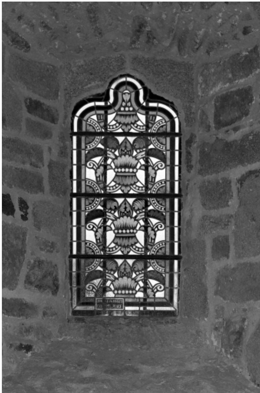
Mur sud, fenêtre 3, vue générale.
