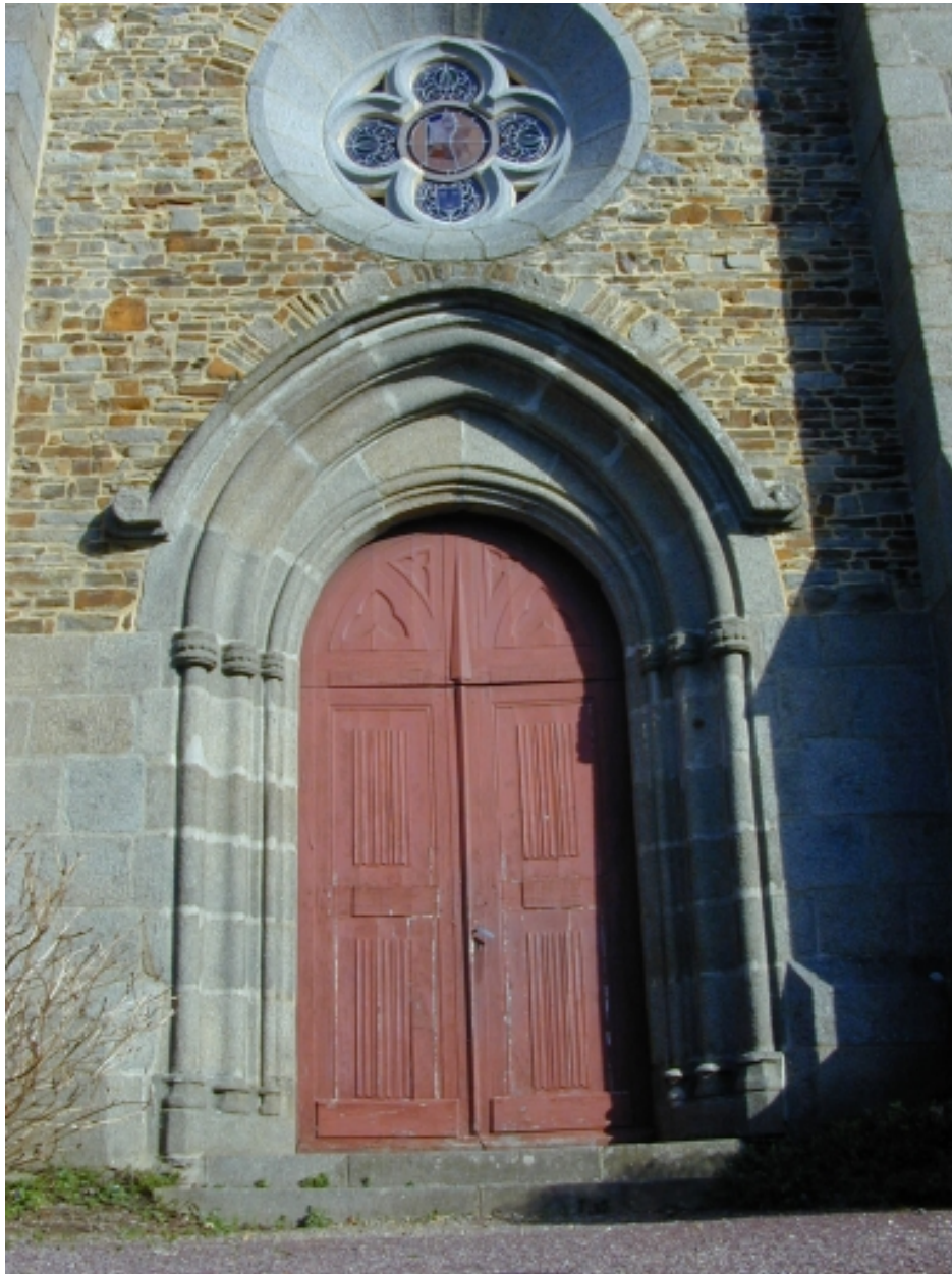
Longère sud, porte du XVe siècle réemployée : vue générale sud
