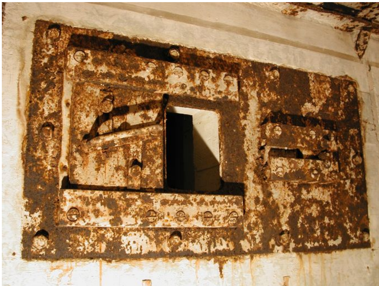
Vue du créneau blindé de gauche
