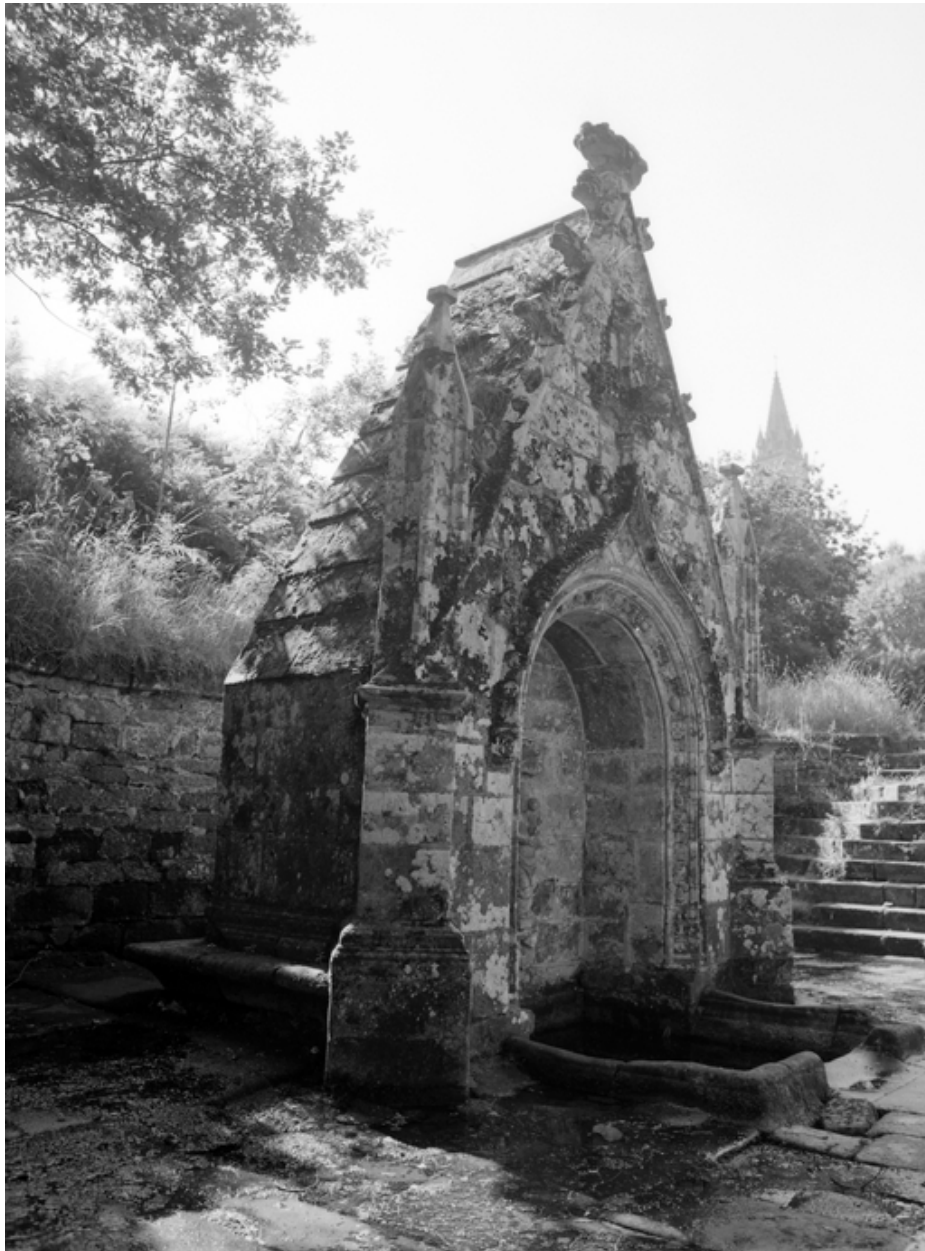
Vue générale nord-ouest
