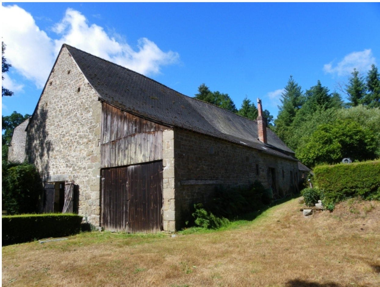
Métairie, façade postérieure.
