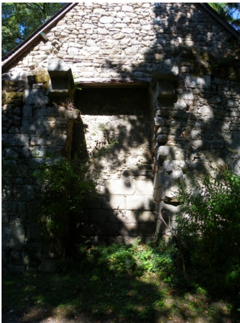
Chambre des Coëtlogon, ancienne cheminée.
