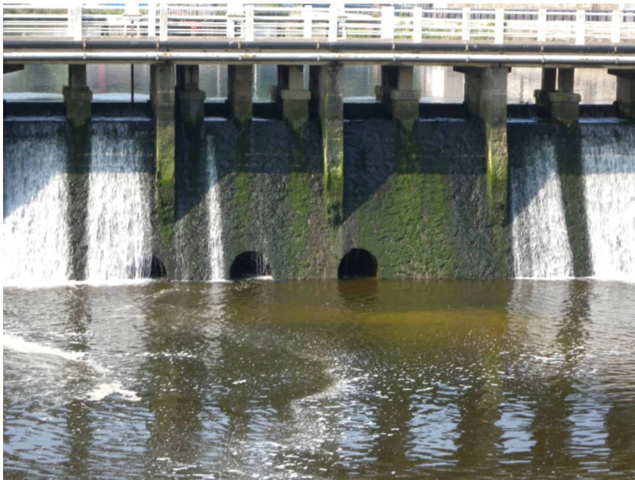
Vue des portes à marée en pierre de taille du pont déversoir
