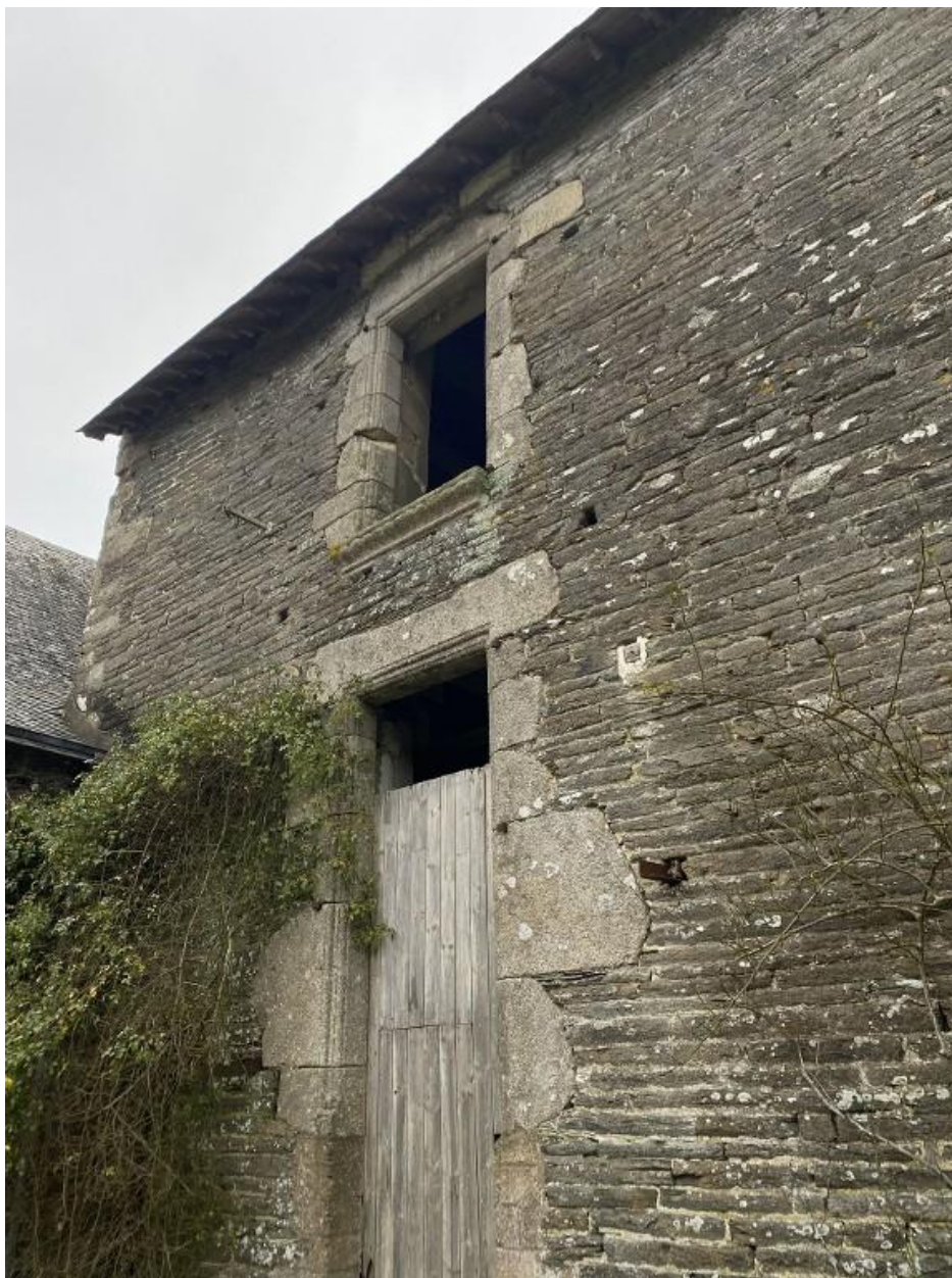
Élévation ouest, détail
