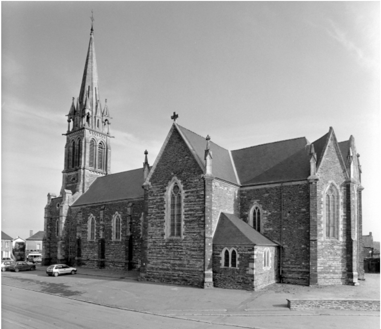
Elévation Sud : vue générale
