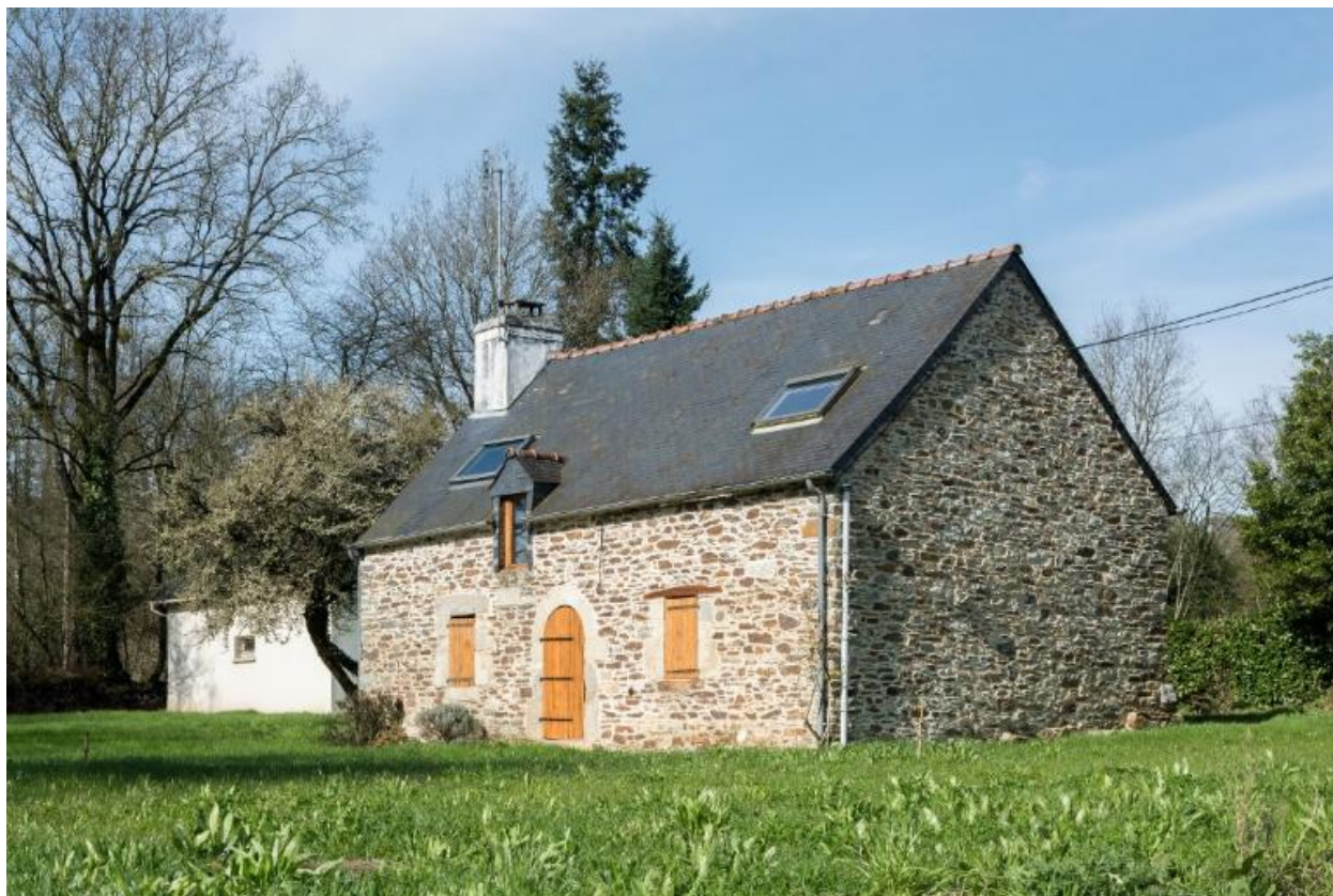
Quilliouzel. Maison de blanchisseurs, 1649. Vue générale sud-est
