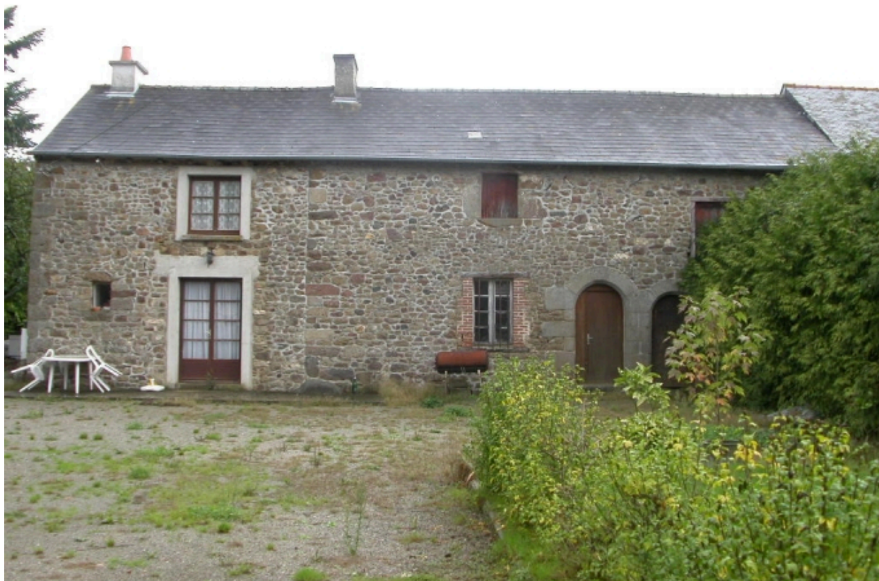
Vue générale sud
