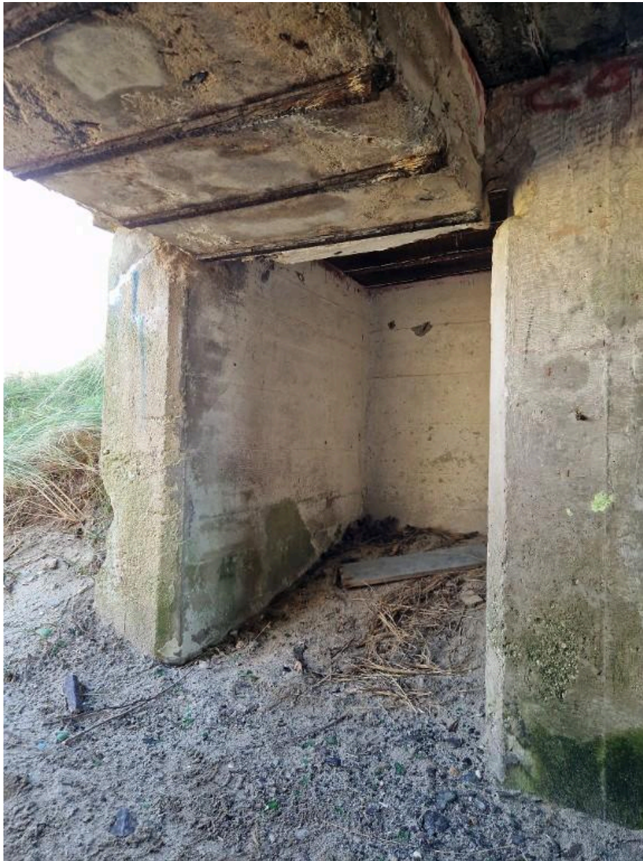
Vue intérieure : niche à munitions (à gauche de l'entrée)
