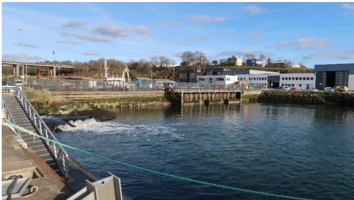
Aire de réparation navale : porte de la forme de radoub
