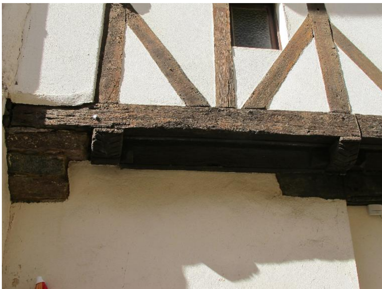
Maison, élévation est : partie inférieure du pan-de-bois (état en 2012)
