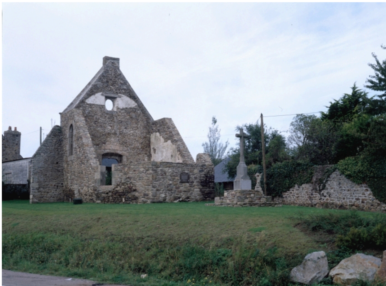
Elévation Est : vue générale
