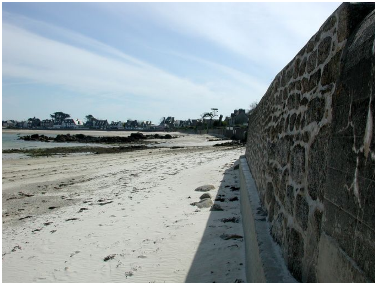
Vue de la plage de Pontusval : à droite, mur de soutènement en maçonnerie de granite faisant digue (état en 2003)
