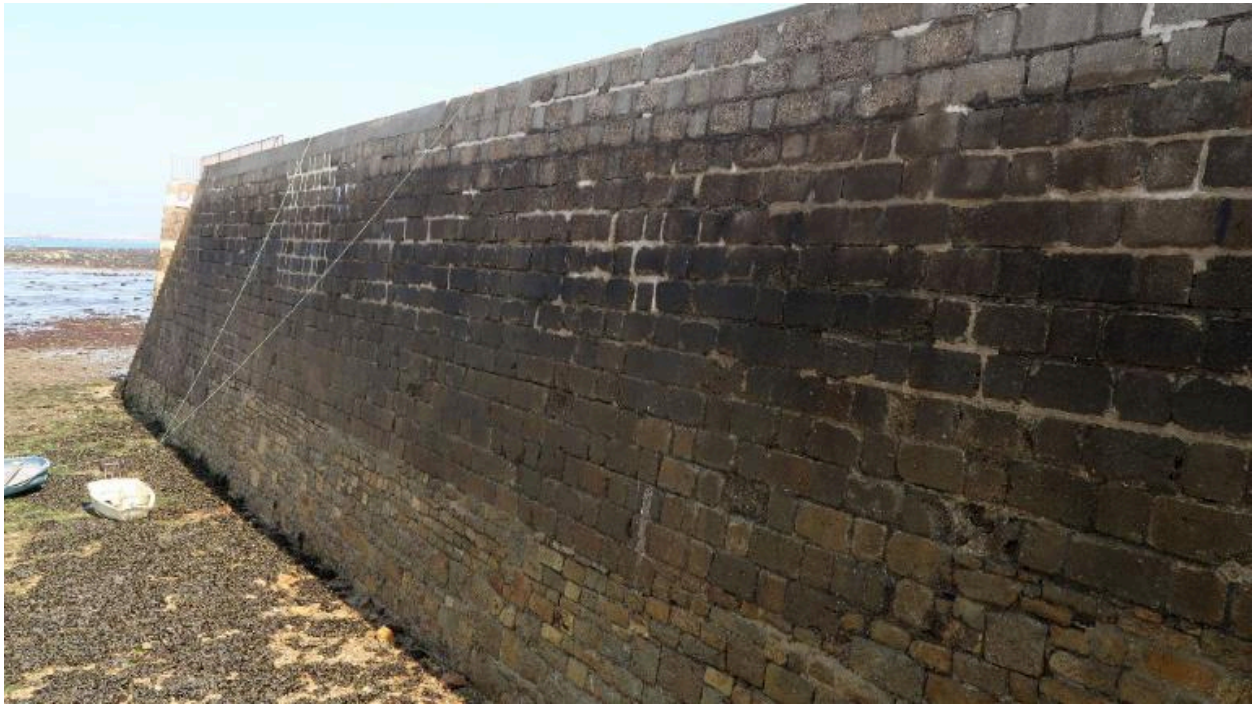
Vue de la jetée de Pen ar Vill, maçonnerie du mur côté Ouest
